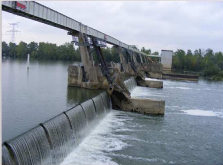
BARRAGE DE LA VILLE DE DRACÉ (FRANCE) DAM AT DRACE (FRANCE)
