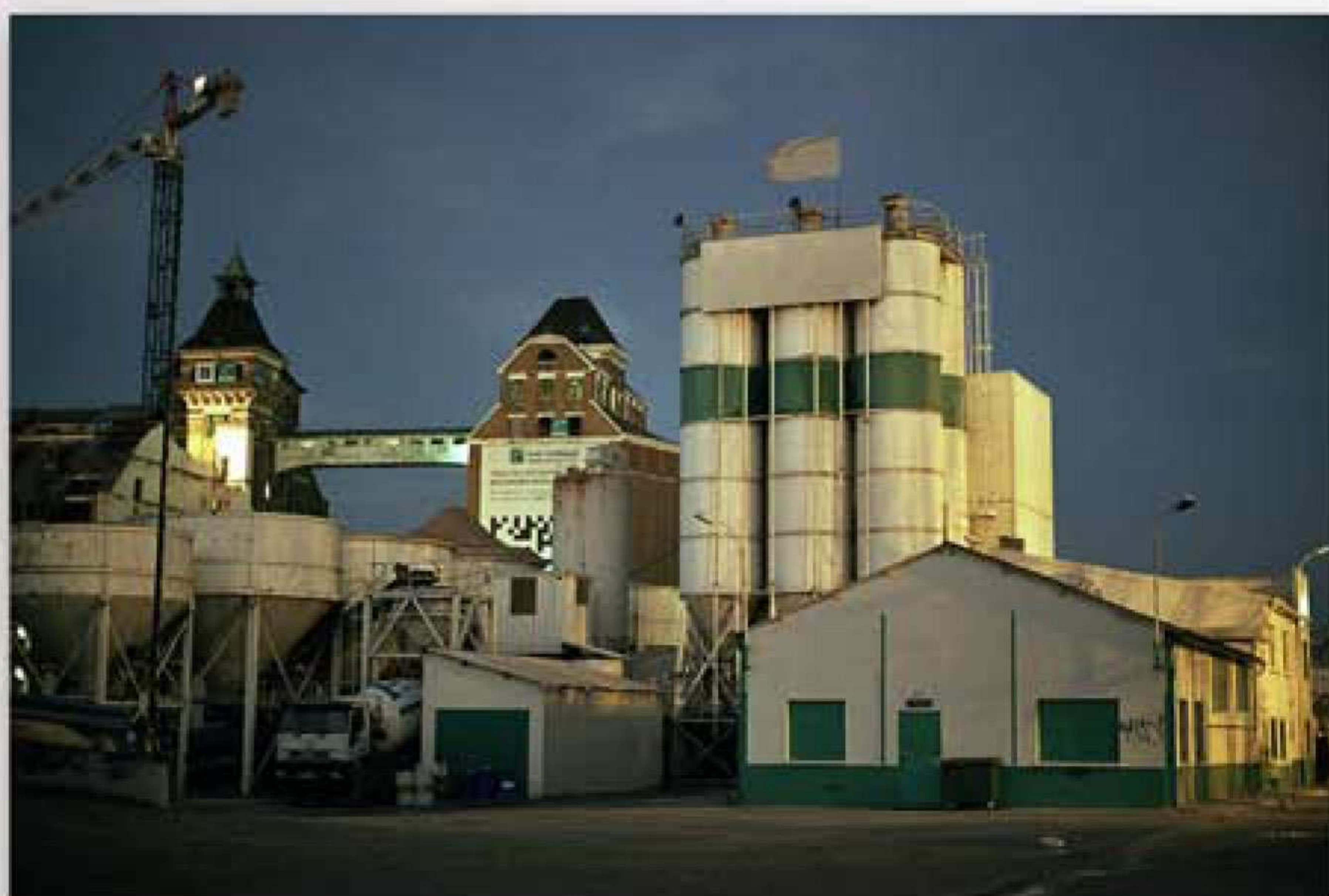
Цементное производство // Cement works
